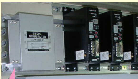
大型部品も2本のレールを使用してフリーナットで取付けできる
