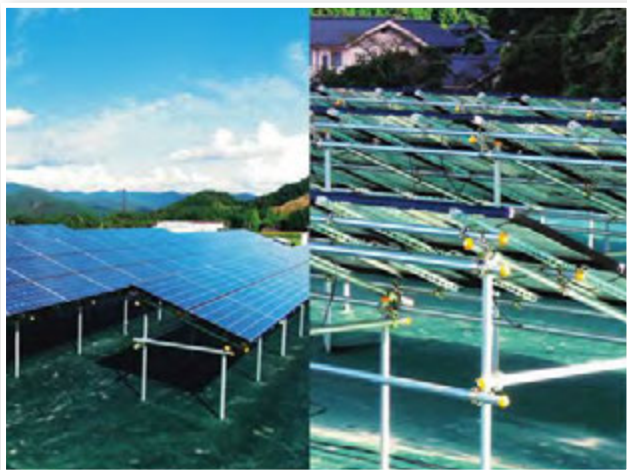
太陽光パネル架台単管+L-40W
