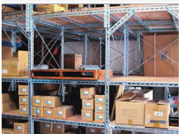
重量棚 L-40Wをコンパクトブレースで耐震補強
