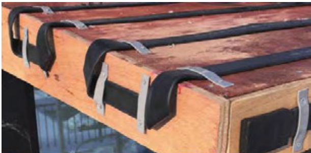
北海道の融雪工事現場
